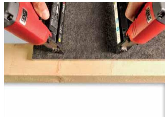
Für eine fugenlose Montage werden die Platten in Längsrichtung um 45 cm versetzt verlegt, um Kreuzfugen zu vermeiden.
